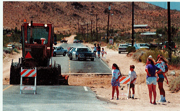
2 Eine Verwerfung östlich von Los Angeles verläuft quer über die Strasse. Die aufgebauten Spannungen haben sich 1992 mit einem Beben der Stärke 7,3 gelöst. Die Strasse wurde dabei zerrissen und um drei Meter versetzt.
